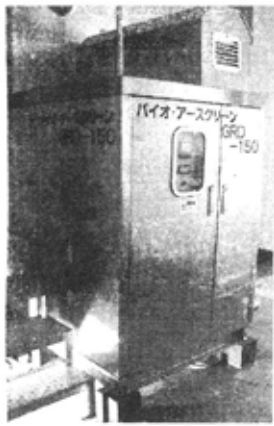
し渣消滅装置
